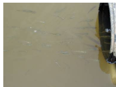
電線管の排水路側末端に集まる魚類
