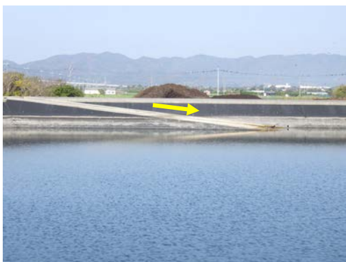
施設内へ下りるスロープの設置例
