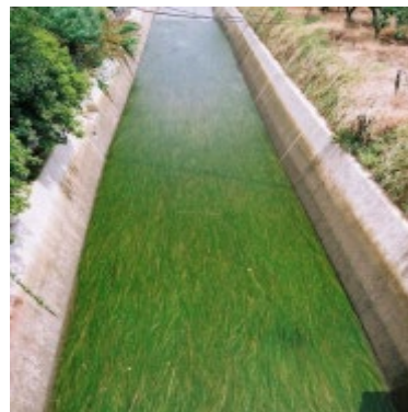
環境配慮対策施工後の水路
