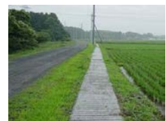
蓋が設置された水路
