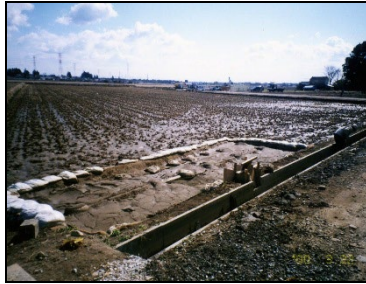
水田を借り入れ沈砂池として利用
