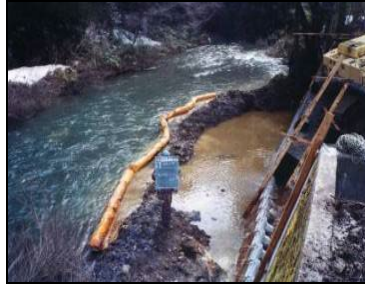
濁水防止フェンスによる抑制
