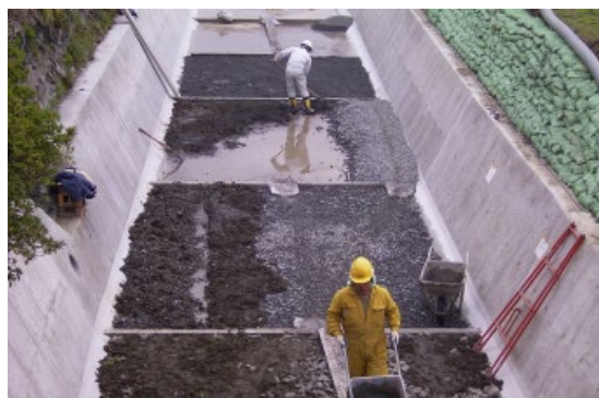
環境配慮対策施工状況
