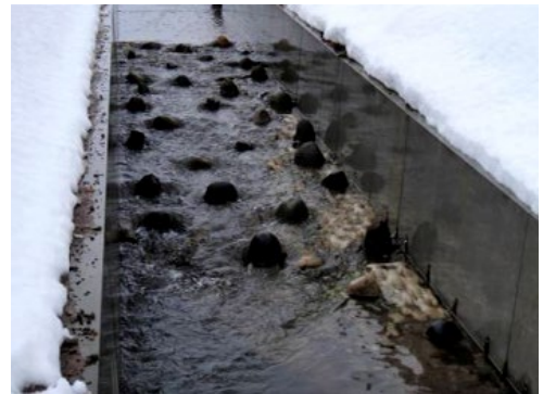
全断面魚道の例（下舌・上黒谷地区（福井県大野市）） 出典）農林水産省農村振興局整備部設計課（2011）：水田生態系の保全に視点をおいた整備技術の解説書
