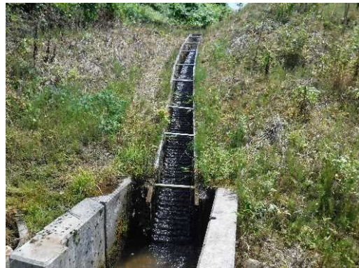
波付きフリュームの設置状況
