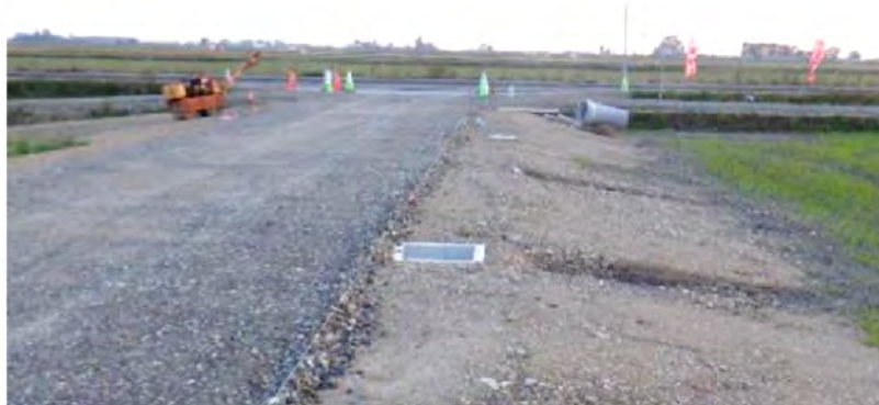
写真-4.4.1 埋設した給水栓 7)
