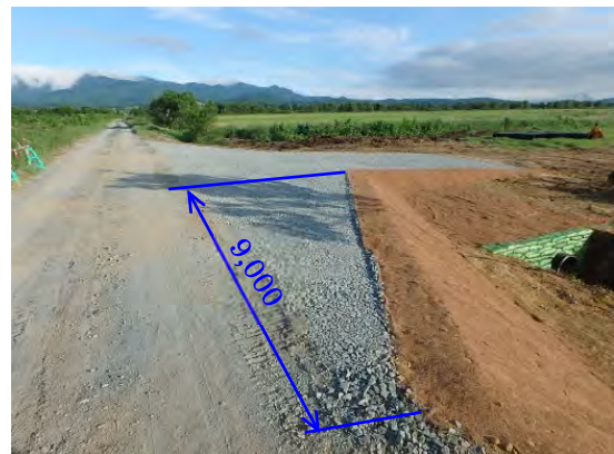
図-4.3.21 進入路の隅切り部分を拡幅した事例 7)
