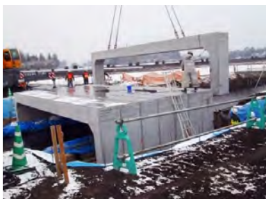
28 写真-4.4.2 水路横断工として門形カルバートを用いた事例
