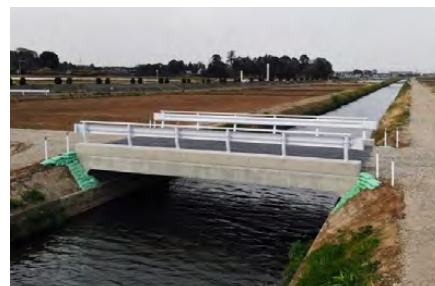
28 写真-4.4.2 水路横断工として門形カルバートを用いた事例
