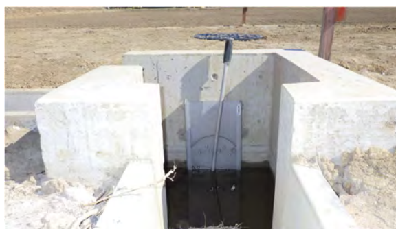
写真-4.7.2 既設水路と管路接続部のゲート
