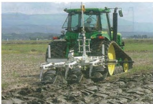
19 写真-5.4.1 運土量削減型整地工法による作業状況（左：表土と下層土の反転、右：運土・整地）
