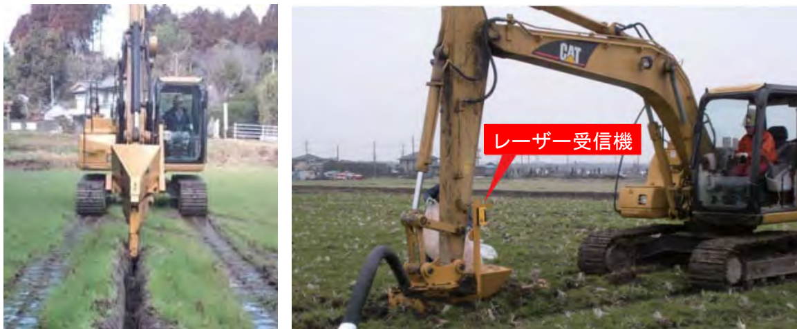
10 図-5.4.5 非開削式暗渠工法（アーム式ベストドレーン工法）の作業状況
