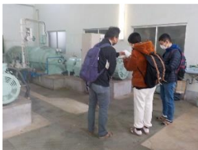
現地調査の様子
