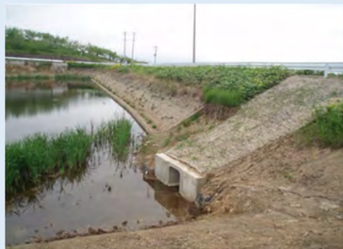
暗渠工法によるため池廃止事例
