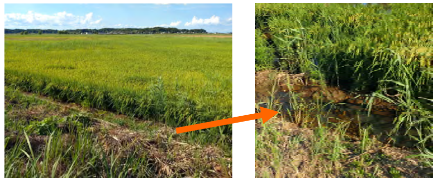
額縁明渠の設置状況
