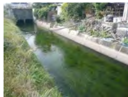
環境配慮対策実施後の水路
