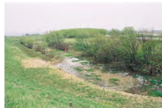
施工後における回避区間の状況
