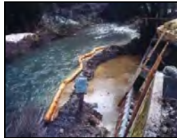
濁水防止フェンスによる抑制
