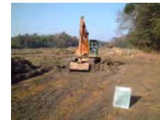
現況表土埋め戻しまでを実施
