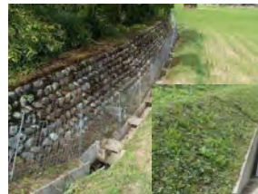
蓋版工の状況
