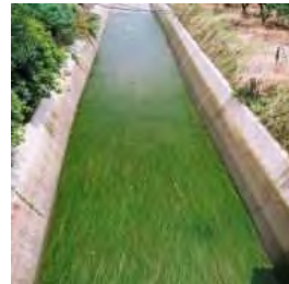
環境配慮対策施工後の水路
