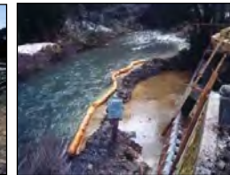
濁水防止フェンスによる抑制
