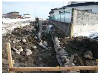
石積み水路の改修 (元泉地域農地・水・環境保全組織（山形県河北町）)
