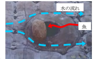
窪みによる水の流れと魚の移動の考え方
