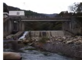
頭首工（改修前）
