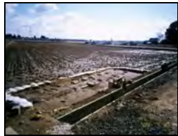
水田を借り入れ沈砂池として利用
