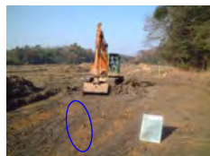
現況表土埋め戻しまでを実施
