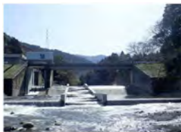
頭首工（改修後）
