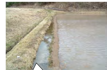
小水路の設置状況
