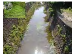
事業実施前の水路
