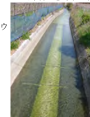
環境配慮対策改善後の水路
