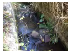
現場打ち魚道
