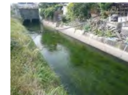
環境配慮対策実施後の水路
