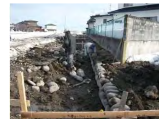
石積み水路の改修
