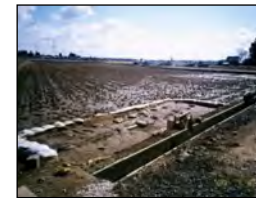
水田を借り入れ沈砂池として利用
