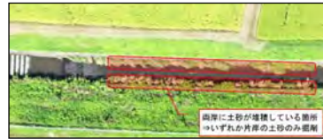
実証区間の二面装工区間
