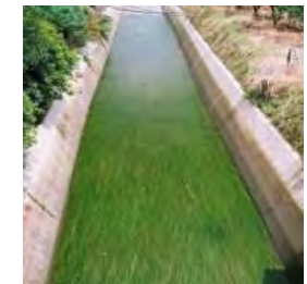
配慮対策施工後の水路
