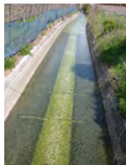
環境配慮対策改善後の水路
