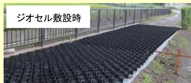
図-4.4.8 わだち掘れを軽減するジオセル（ジオセンチックスの一つ）舗装の例
