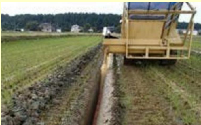
水田下に暗渠排水を設置する様子
