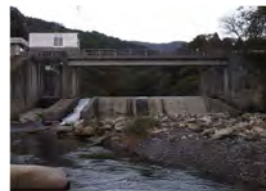
頭首工（改修前）
