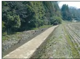
現況水路保全区間
