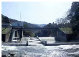
頭首工（改修後）
