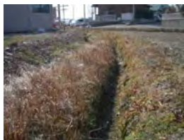
回避された土水路
