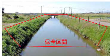
回避された土水路
