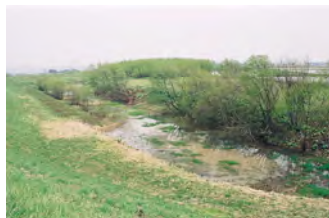
施工後における回避区間の状況
