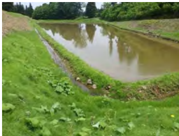
「江」の設置状況
