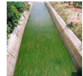
配慮対策施工後の水路
