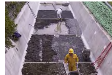
環境配慮対策施工状況
