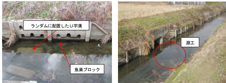
淵工とU字溝の組合せによる配慮対策工
