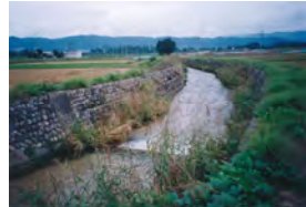
現況の排水路の状況(流速が速く、魚類の産卵場・生息場としての質は高くなかった)
