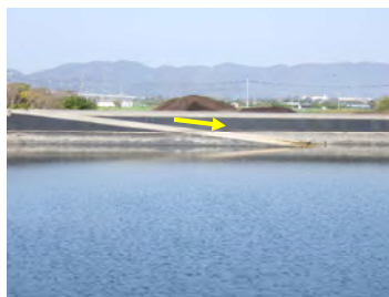
施設内へ下りるスロープの設置例
