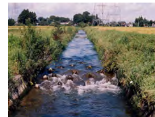
整備後の状況（急勾配側の左岸は流れが速く流量が多い、緩勾配側の右岸は水深が浅くなっている）
