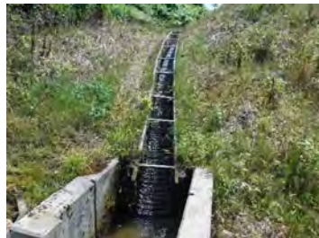
波付きフリユームの設置状況
