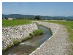
整備後3年目の状況 (多様な流れにより魚類の生息環境の質が向上している。)
