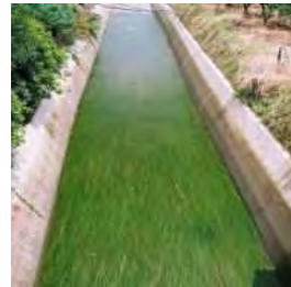
環境配慮対策施工後の水路
