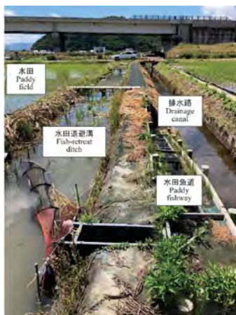
水田退避溝の設置状況
