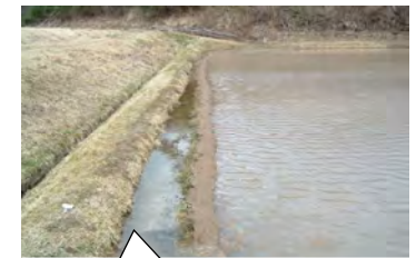
小水路の設置状況
