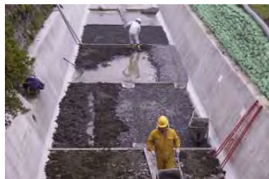
環境配慮対策施工状況
