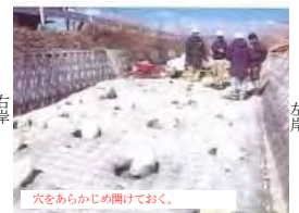
高強度マットにより形成された斜面に粗石を設置した状況
