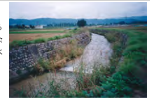
現況の排水路の状況(流速が速く、魚類の産卵場・生息場としての質は高くなかった)
