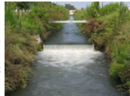
現況の状況 (落差工により、魚類等の移動経路が分断されていた。)
