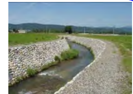
整備後3年目の状況 (多様な流れにより魚類の生息環境の質が向上している。)
