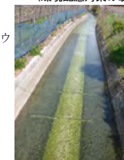
環境配慮対策改善後の水路
