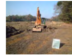
現況表土埋め戻しまでを実施
