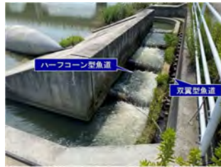
伏樋堰に設置された魚道
