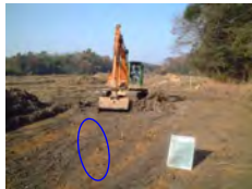
現況表土埋め戻しまでを実施
