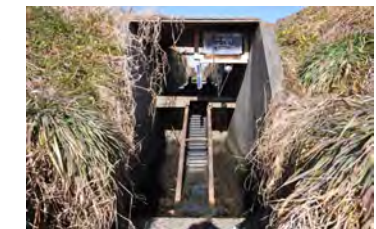
移動障害解消のため、追加整備された水路魚道
