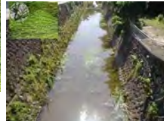
事業実施前の水路
