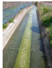
環境配慮対策改善後の水路
