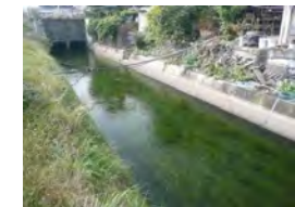
環境配慮対策実施後の水路
