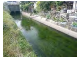
環境配慮対策実施後の水路
