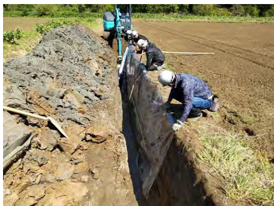
写真-3.8.1 遮水シートの施工事例
