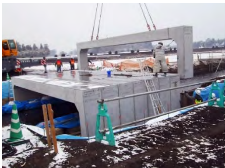
写真-3.4.2 水路横断工として門形カルバートを用いた事例
