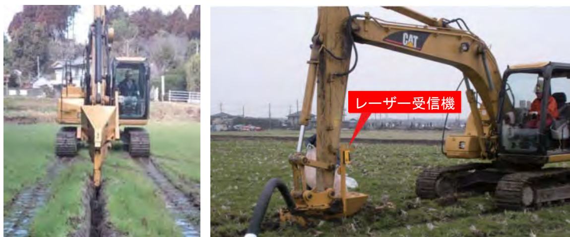
図-5.4.5 非開削式暗渠工法（アーム式ベストドレーン工法）の作業状況
