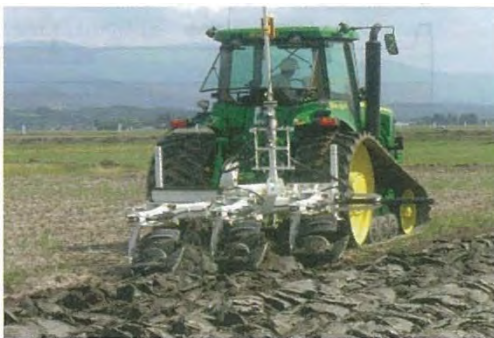
写真-5.4.1 運土量削減型整地工法による作業状況（左：表土と下層土の反転、右：運土・整地）
