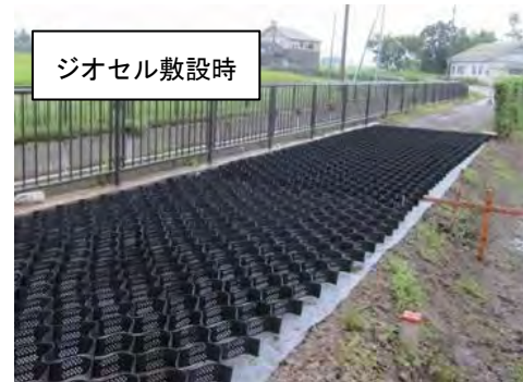
図-3.4.10 ジオセル（ジオセンチックスの一つ）による舗装の例
