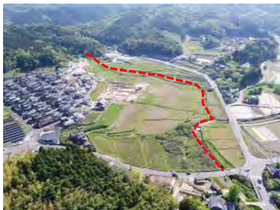
整備前 (赤線に大きな傾斜あり)
