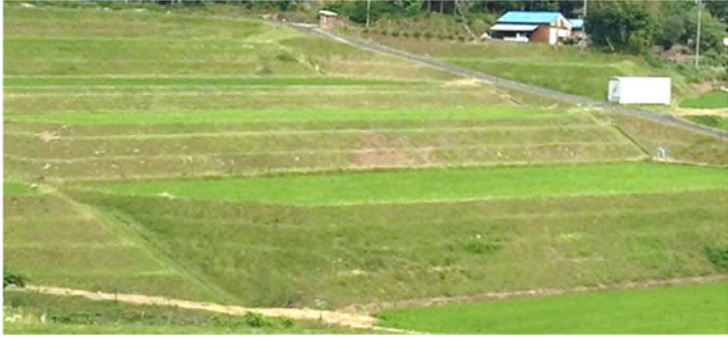
写真-4.3.1 地被植物（グラウンドカバー・プランツ）によって畦畔法面を被覆した事例
