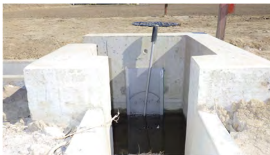
写真-3. 7. 2 既設水路と管路接続部のゲート
