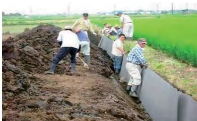
写真-3.8.1 遮水シートの施工事例
