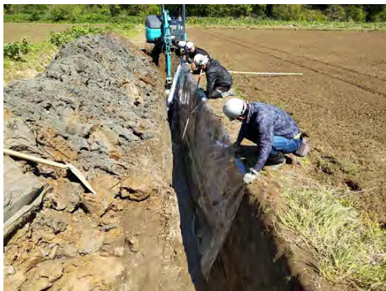
写真-4.8.1 遮水シートの施工事例
