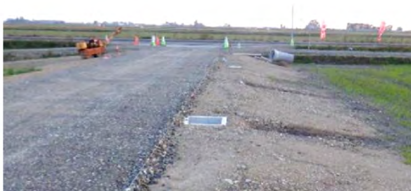
写真-3.4.1 埋設した給水栓 7)
