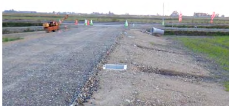
写真-4.4.1 埋設した給水栓 7)
