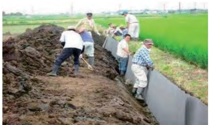
写真-4.8.1 遮水シートの施工事例
