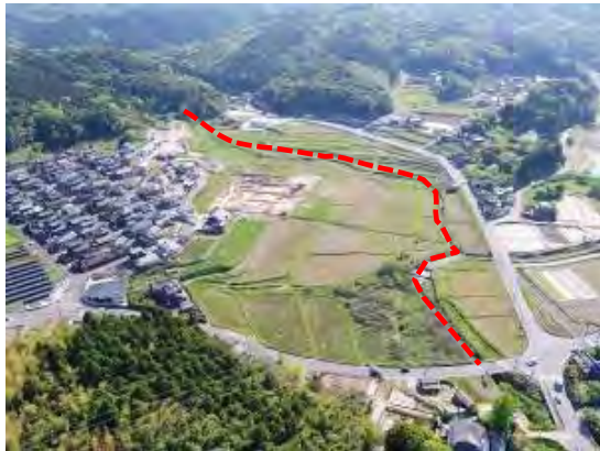
23 整備前 (赤線に大きな傾斜あり)
