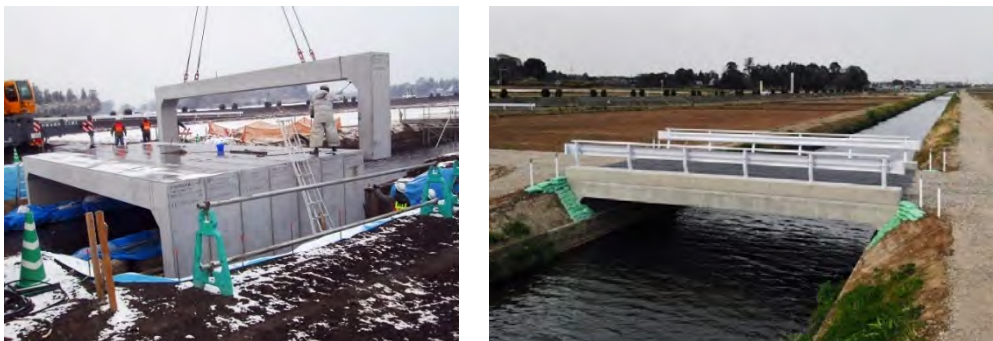
27 写真-3.4.2 水路横断工として門形カルバートを用いた事例
