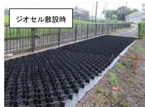
7 8 図-3.4.10 ジオセル（ジオセンチックスの一つ）による舗装の例
