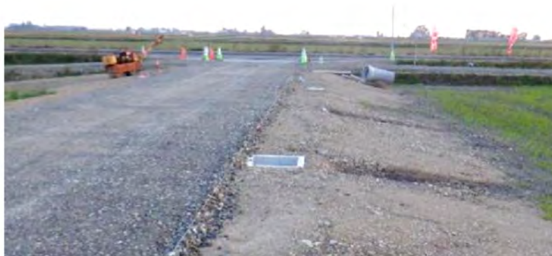
写真-3.4.1 埋設した給水栓 7)
