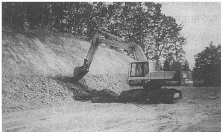
図-13.2.8 切土法面の仕上げの状況
