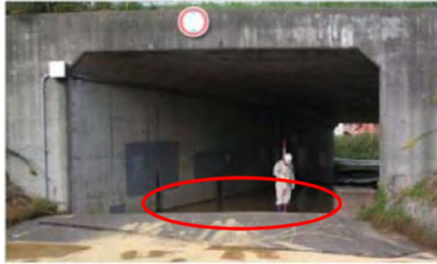
図-10.2.6 カルバートの沈下による帯水 22)
