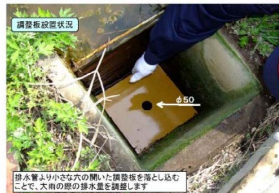
写真-16.1 調整板設置状況
