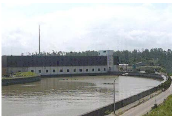
写真-15.6 事業実施前の排水機場
