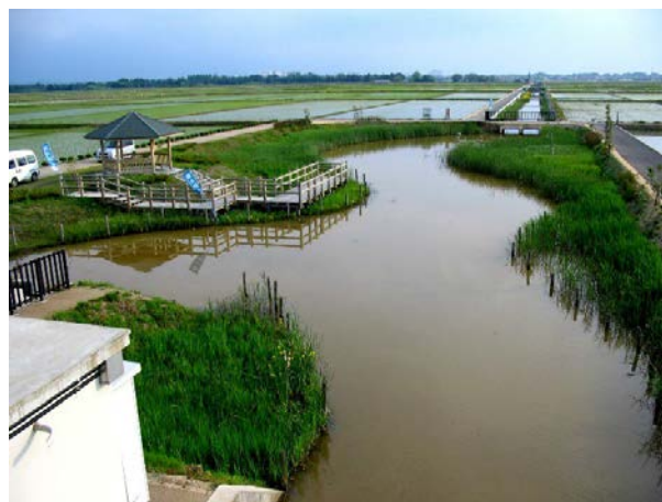
写真-15.16 多自然型浄化池設置状況
