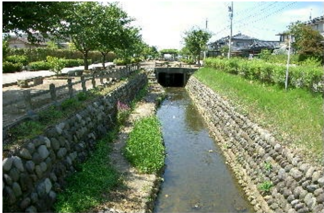
写真-15.5 事業実施後の排水路
