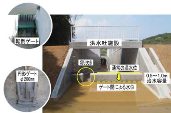
図-16.9 洪水吐放流ゲート等の設置
