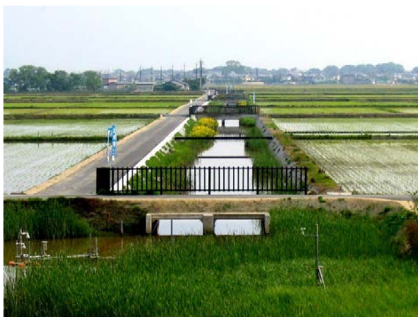
写真-15.15 多自然型排水路設置状況
