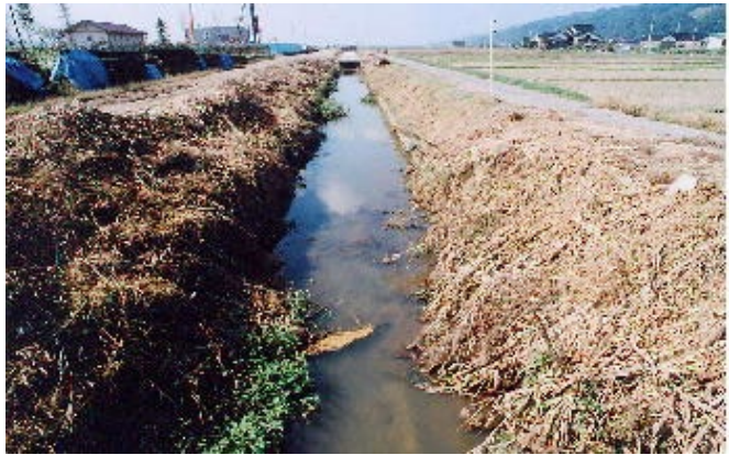
写真-15.4 事業実施前の排水路
