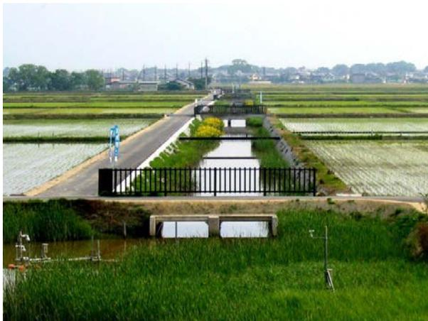
写真-15.15 多自然型排水路設置状況
