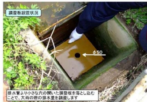
写真-16.1 調整板設置状況
