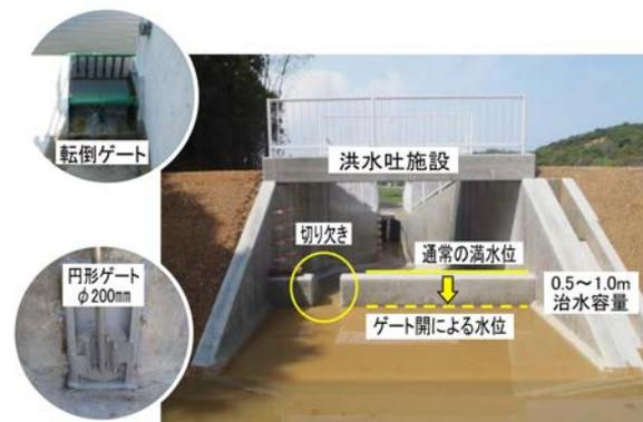
図-16.9 洪水吐放流ゲート等の設置
