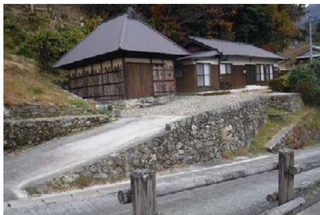
施工後の景観形成(修景された納屋の様子)
