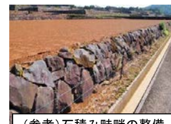
(参考)石積み畦畔の整備
