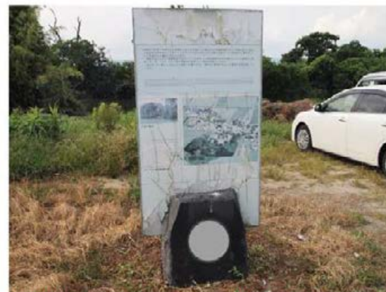
【素材が経年劣化した看板】
