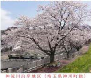
【沈砂池を周遊できる管理用道路】
