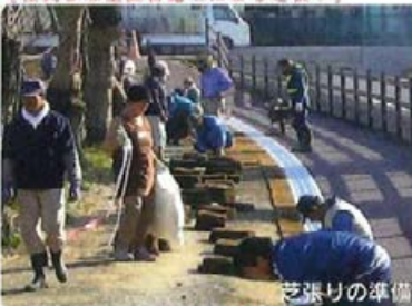
【住民参加型直営施工による芝張り】
