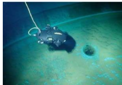
水中ドローンによる河床低下・洗堀の点検
