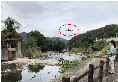
無人航空機（UAV）による堰体の摩耗状況等の点検
