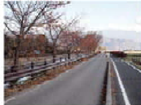
〔水路の防護柵〕
