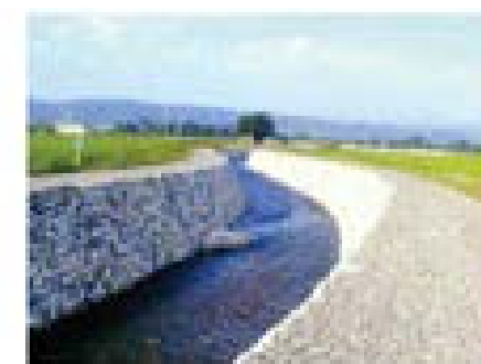
〔自然石空積工法を採用した幹線排水路〕
