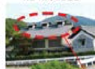
高窓のある切妻屋根
