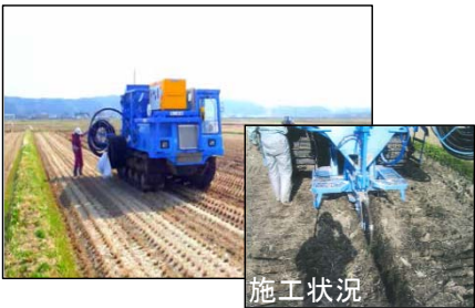
【非開削工法により本暗渠を施工】
