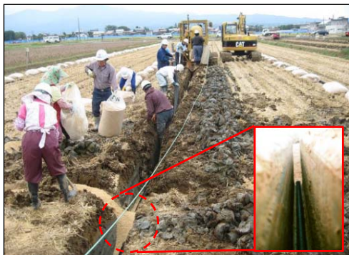
本暗渠の施工状況
