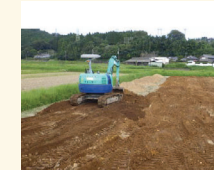
土層改良（客土）
