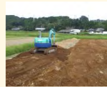
土層改良（客土）
