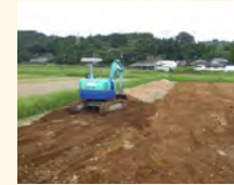
土層改良（客土）
