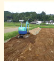
土層改良（客土）
