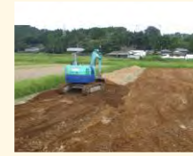
土層改良（客土）
