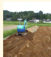
土層改良（客土）
