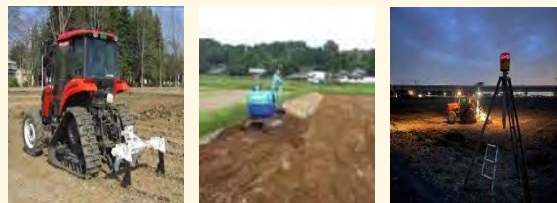
〔例〕排水対策（暗渠） 土層改良（客土） 傾斜均平
