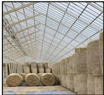
倉庫の整備 （広域流通拠点の整備）
