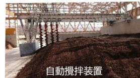
自動攪拌装置
