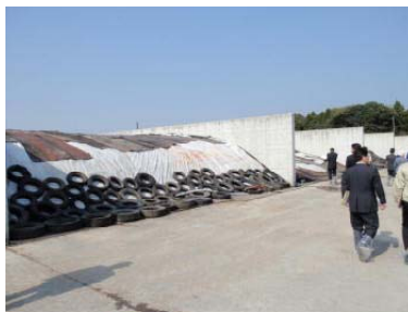
バンカーサイロ8基
