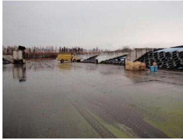
バンカーサイロ17基
