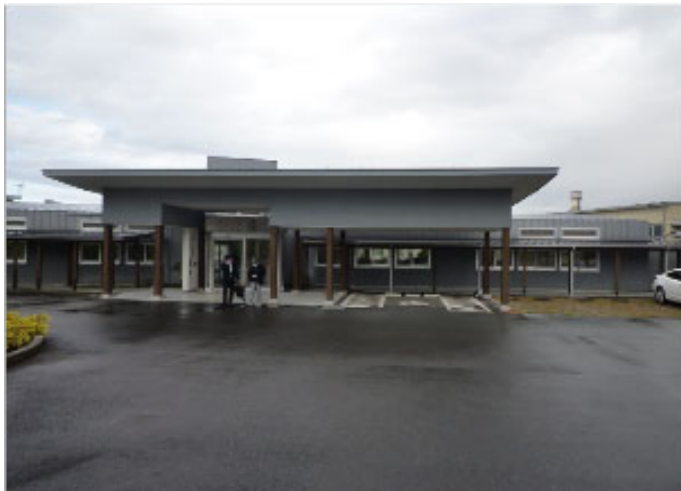
家畜保健衛生所外観
