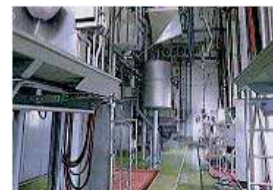
食肉解体施設
