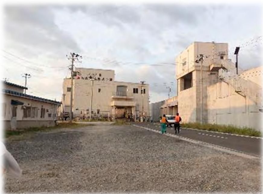
高さ9.7m、延長1.6kmの防潮堤 が設置されている
