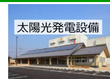
太陽光発電設備
