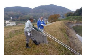
ため池の現地パトロール
