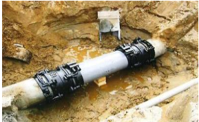
漏水防止のための整備
