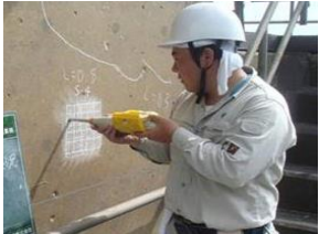
老朽化した施設の機能診断
