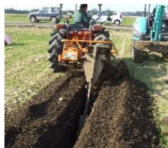
暗渠排水の整備
