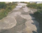
農道の窪みの補修
