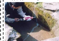
水路のひび割れ補修
