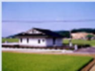
農業集落排水施設
