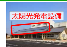
太陽光発電設備
