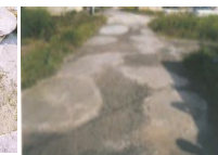
農道の窪みの補修
