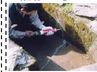
水路のひび割れ補修
