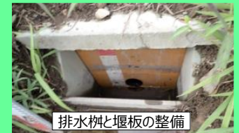
排水柵と堰板の整備
