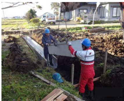
用水路更新（山形県）
