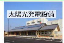
太陽光発電設備
