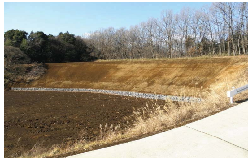
復旧完了状況 (平成24年1月)
