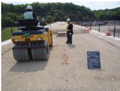
復旧工事状況 (平成24年5月)
