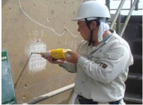
老朽化した施設の機能診断
