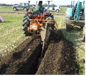
暗渠排水の整備
