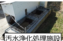
汚水浄化処理施設
